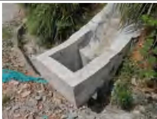
截水沟末端设置混凝土沉沙池
