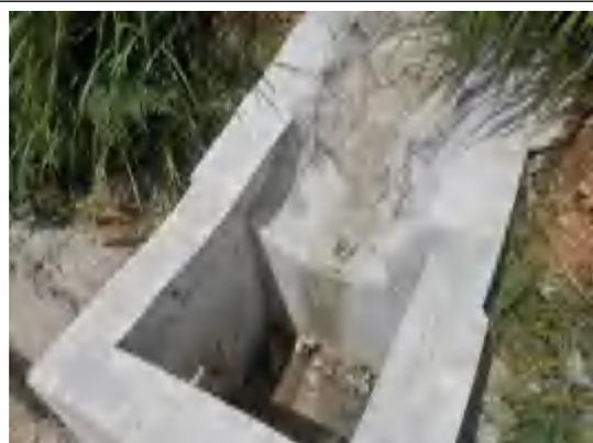
截水沟末端设置混凝土沉沙池
