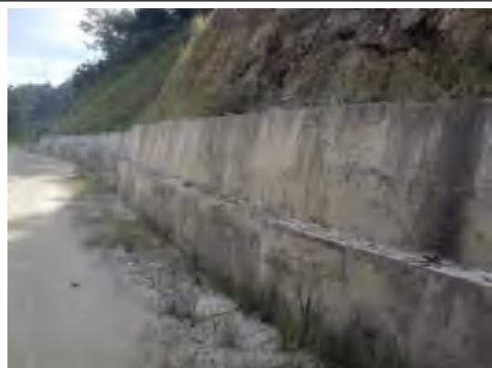
道路上边坡设置浆砌石挡墙护坡
